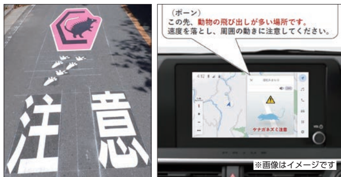
図8 夜間の視認性を高めた高輝度の路面表示（左）、カーナビゲーションでの注意喚起（右） 9)
