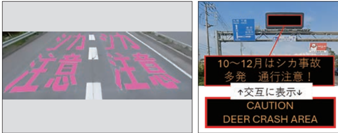
図 9 視認性を高めた高輝度の路面表示（左）、道路情報板での注意喚起（右） 9)
