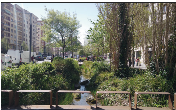
図52 雨水処理を担うビオトープ
