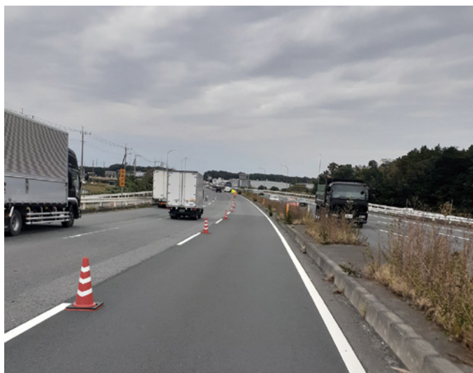
写真 1 技術実証の現場（国道 4 号 古河工区）
