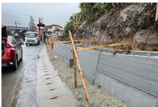
写真1 施工中の重力式擁壁（新庄砕石工業所） 2)
