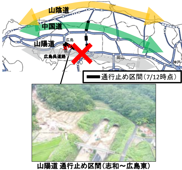
図 2 山陽自動車道 被災状況 5)
