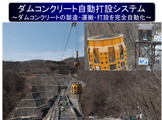
図-3 ダムコンクリート自動打設システム 技術概要挿絵
