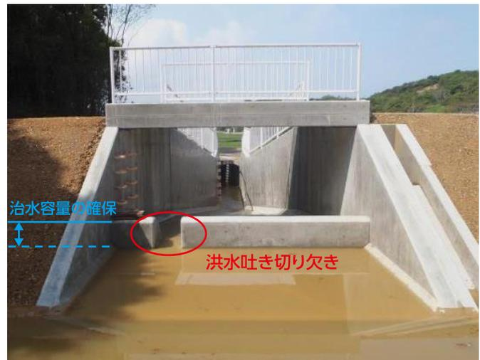
写真-2 ため池の洪水吐に切り欠きを設置し、治水容量を確保した事例
