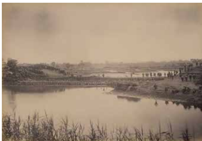
写真 2-2 信濃川大洪水の復旧工事 (土木学会附属図書館 デジタルアーカイブス 『古市公威 旧蔵写真館』「明治 29 年信濃川大洪水」より)
