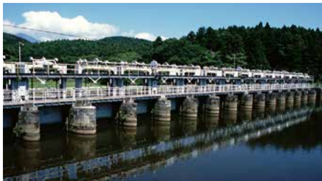
写真 3-2 安積疏水十六橋水門 (知野氏撮影)
