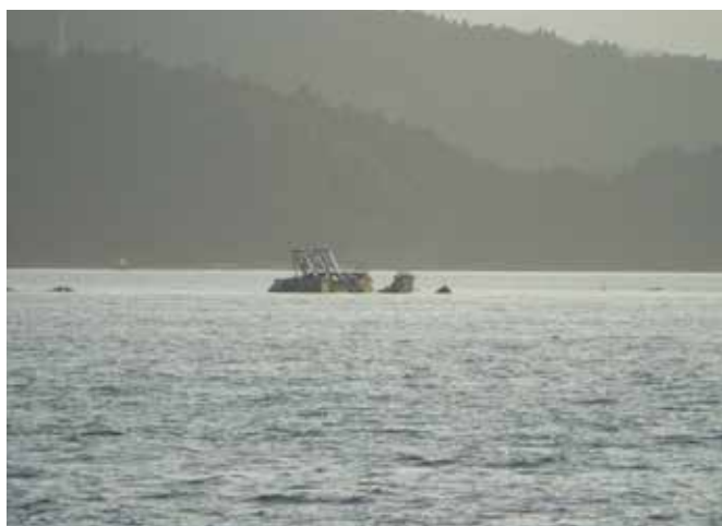
写真 5-4 震災後の釜谷水門（知野氏撮影）
