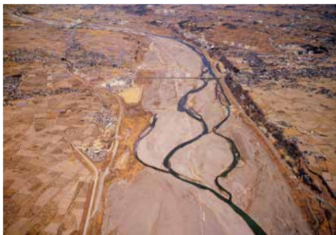
写真 2-3 信玄堤と高岩による治水 (旧建設省甲府工事事務所『空から見た富士川』1988)
