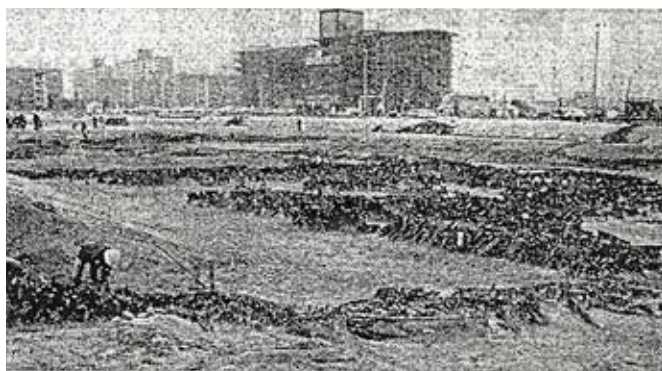
写真 1-2 那珂久平遺跡 (弥生期 / 西日本新聞 1983/12/18) (那珂久平遺跡で出土の大規模な井堰遺構。 数千本の杭にてダム状に造られた)
