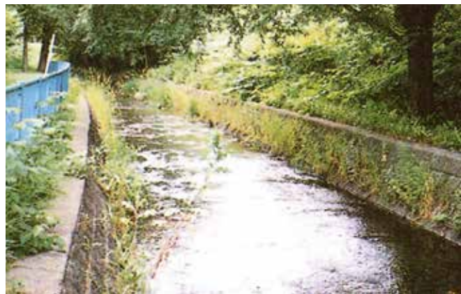
写真 5-1 改修前（出典：島谷幸宏『河川環境の保全と復元』2000）
