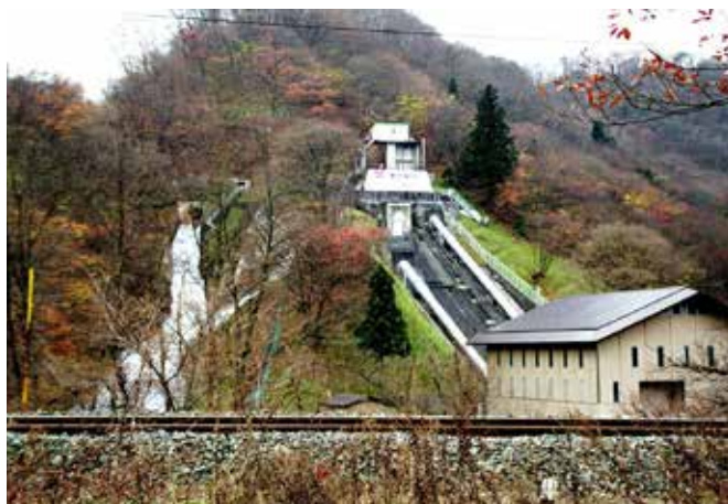
写真 3-3 沼上発電所余水路 (知野氏撮影)
