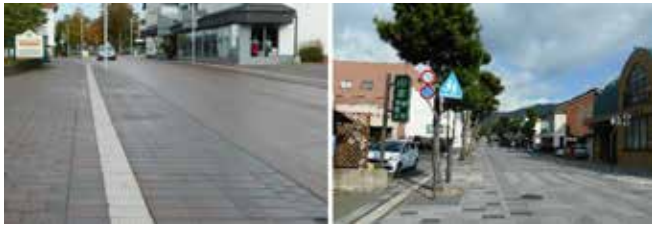
写真-6 車道の歩道寄りを歩道と同じ舗装とし、車道を狭く見せる工夫 (左：ボームテ、右：出雲市)
