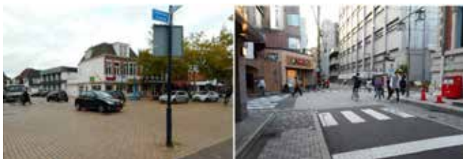
写真-7 交差点の信号を撤去することで、通行者の自主性を尊重し安全性を高める工夫 (左：ドラハテン、右：京都市)
