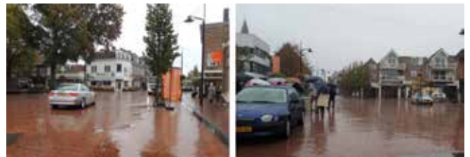
写真-4 ハーレンのシェアードスペース (歩道・車道同様の舗装)
