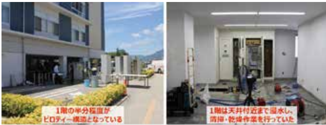
図 4-13 総合病院の被災状況
