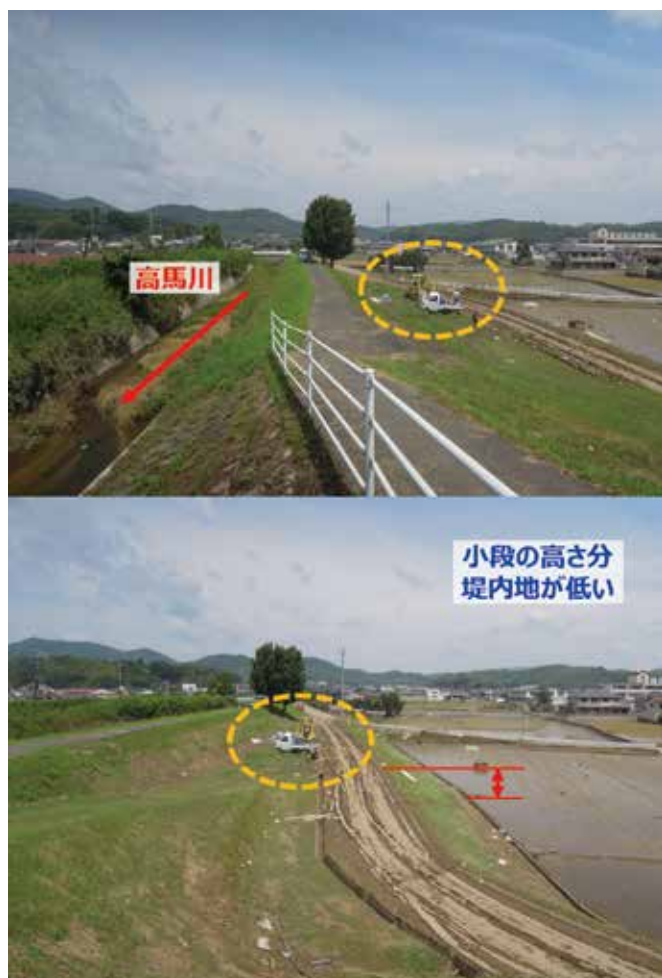
図 3-4 高馬川堤防決壊箇所近傍の堤内地盤高 (軽トラの位置が概ね河床高程度)
