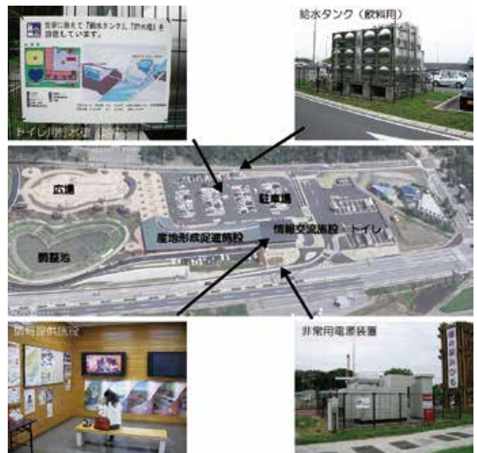
写真 3-5 防災拠点として整備された道の駅
