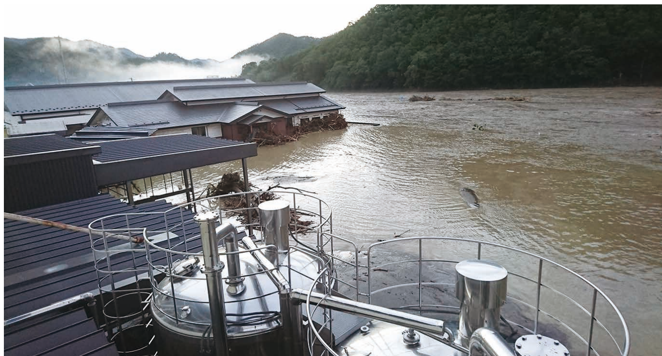
写真-1 岩泉乳業の工場における翌朝の浸水状況
