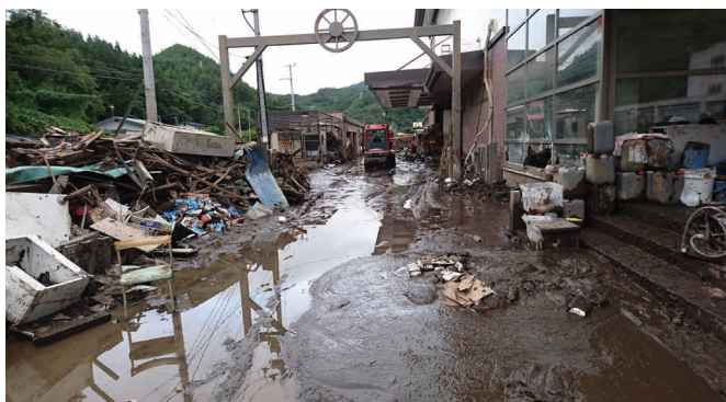
写真-3 本社の社屋横（国道445号との間）の被災状況。
