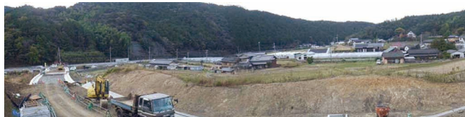
固定カメラから撮影した現場状況
