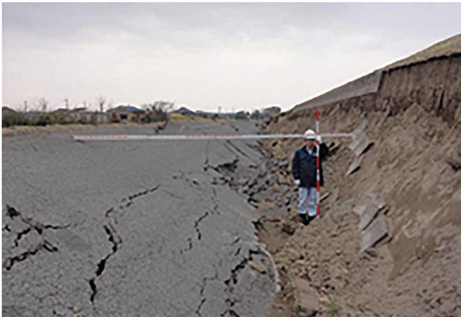
写真-1 利根川 R70.5k 付近 1 堤防沈下状況 (筆者撮影)
