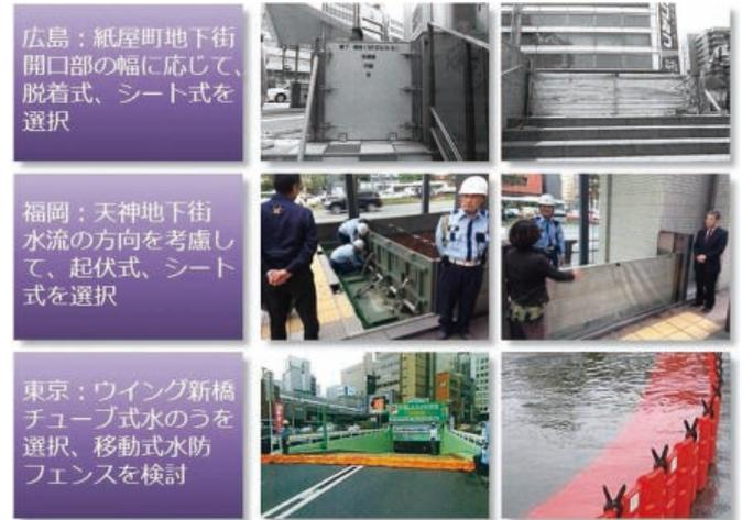
図6-5 浸水防止用設備整備の事例
