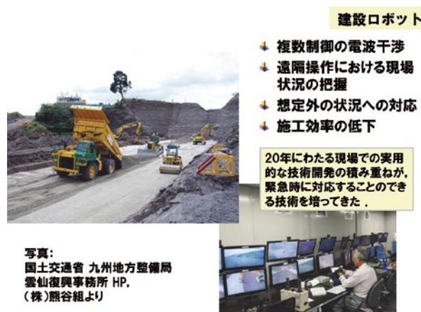
図 4-9 遠隔操作による無人化施工
