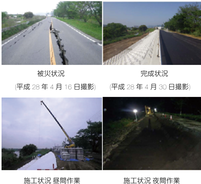
図1.3.2 熊本市南区野田地先（表1.2.1 箇所番号⑩）における緊急復旧工事の状況 [18] より引用
