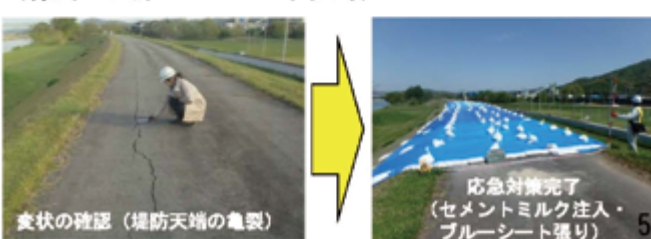
図1.3.1 変状発生箇所における応急対応 [17]より引用
