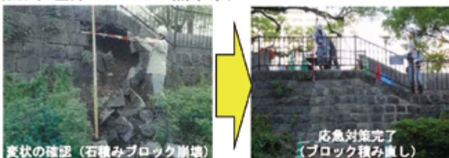
（緑川 左岸16k400m：熊本市）
