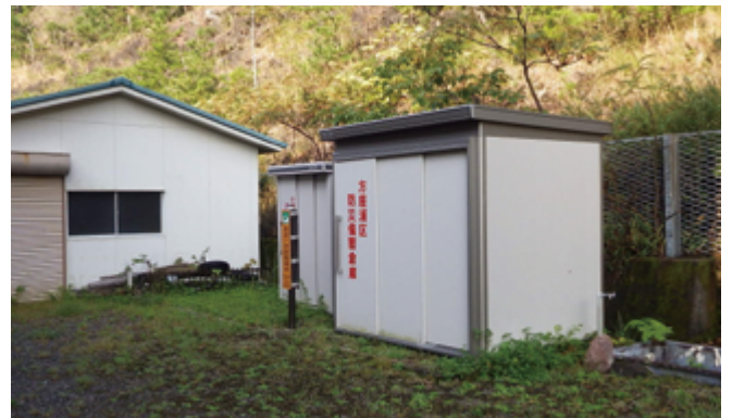
写真8 地区で維持管理する防災倉庫
