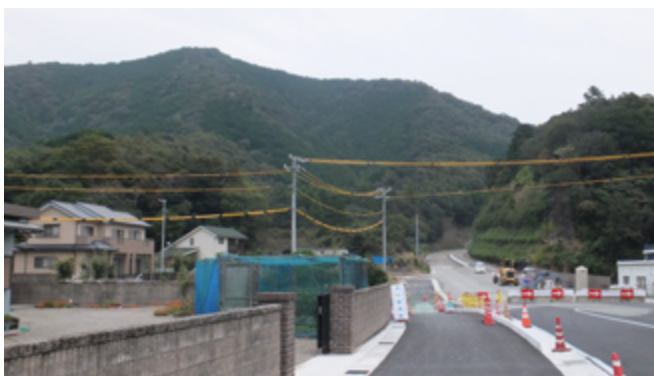
写真3 整備中の国道260号バイパス (左の方には新しい住宅が立ち始めている)
