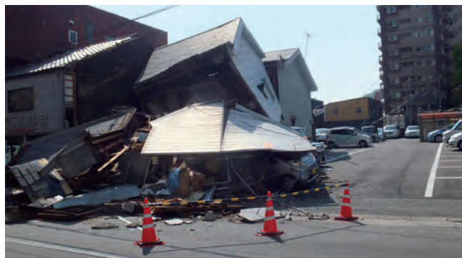
写真3-1 家屋の倒壊 (JICE調査)
