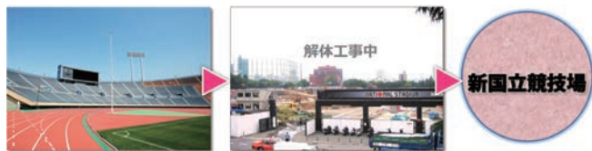
左：写真提供：独立行政法人日本スポーツ振興センター 中：解体工事中の国立競技場（筆者撮影）
