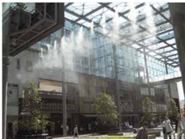
写真2 都市利便増進施設として設置されたミスト装置
