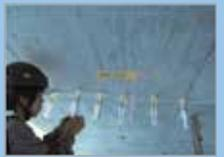
写真：ひび割れ補修工
