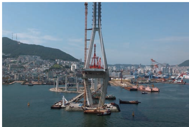
写真 3-4 北港大橋施工状況
