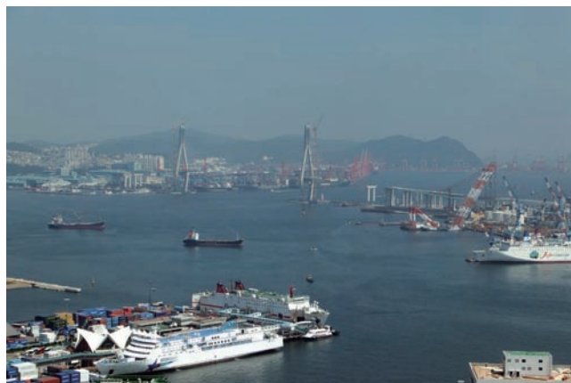
写真 3-3 北港大橋遠景
