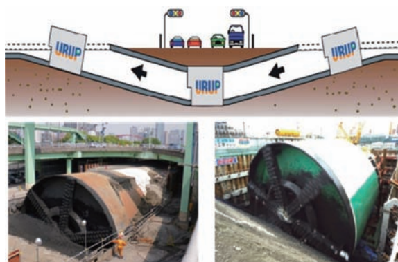
写真－４ URUP工法概要図、地上発進・地上到達
