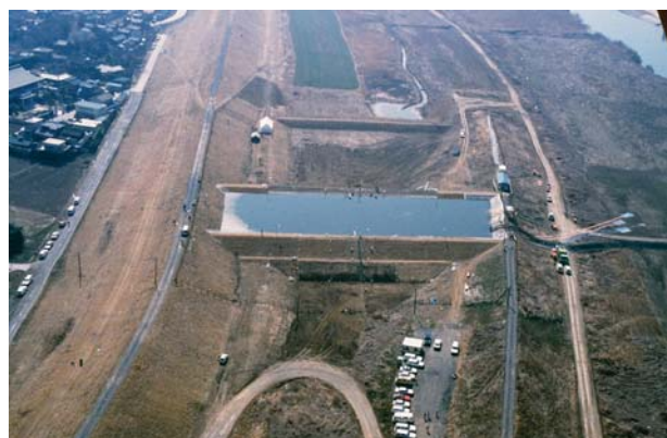
写真-1 江戸川堤防実規模実験サイトの全景
