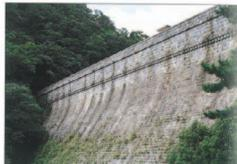
○布引五本松ダム(兵庫県神戸市) 日本で最古の重力式コンクリートダムで、1900(明治33)年に完成した。高さ33m、堤の長さは110mあまりある。
