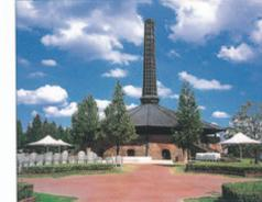
○下野煉瓦製造会社ホフマン窯(栃木県栃木市) ホフマン窯とは、連続して煉瓦を焼くことのできる窯。煙突の高さ34メートル、周囲約100メートル。
