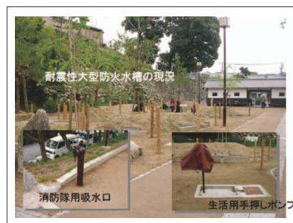
図-12 高台寺公園の雨水貯留システム
