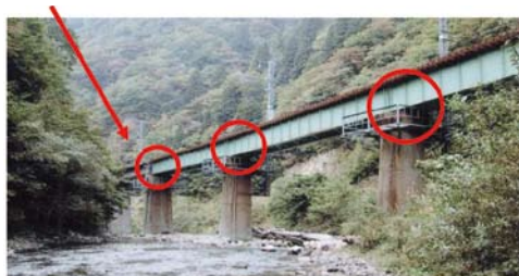
(b) 洗掘検知用傾斜計
