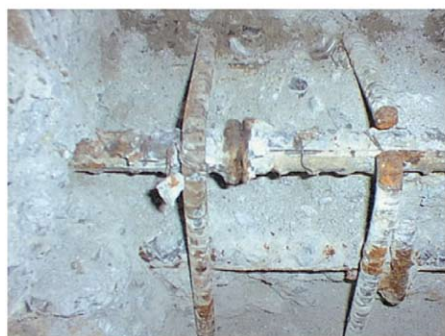
図－５ 鉄筋の破断状況
