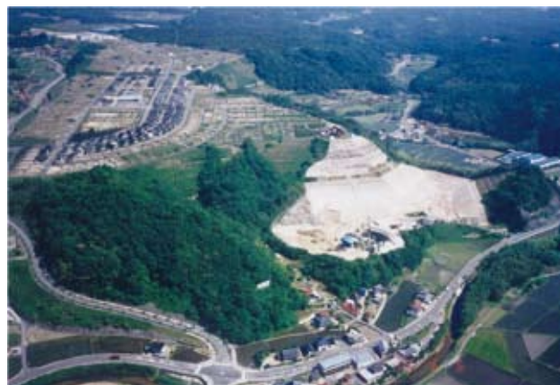
(a) 土取り場全景 造成宅地前面に続く尾根の鞍部を主体に土砂採取
