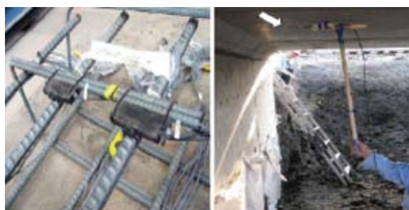
図-10 コンクリート構造物のひずみ計測 （太平洋セメント（株）HPより）
