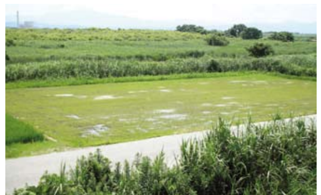
写真－1 信濃川左岸 -1.0k（堤防天端から堤内地側を撮影。白く点在する部分が噴砂跡）
