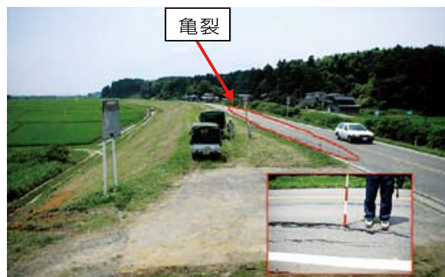
写真-5 信濃川左岸 1.0k (下流から上流を撮影)
