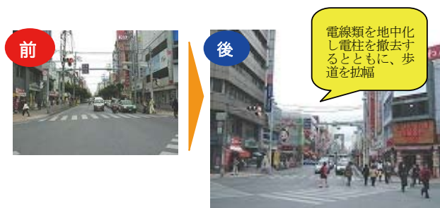
図－16 国際通り線（那覇市）電線共同溝の整備
