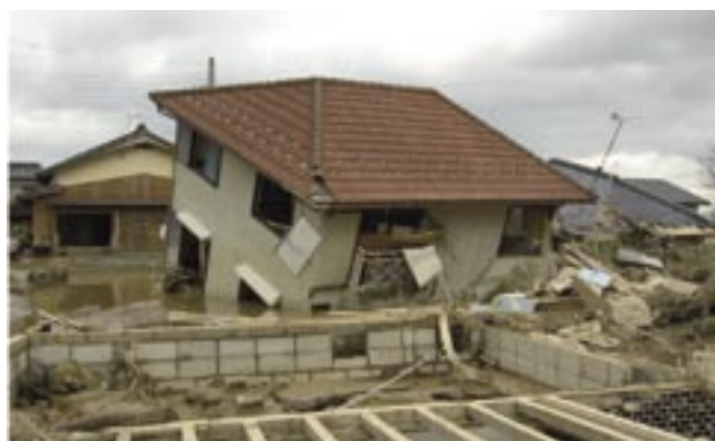
写真－１ 円山川水害の被害状況写真
