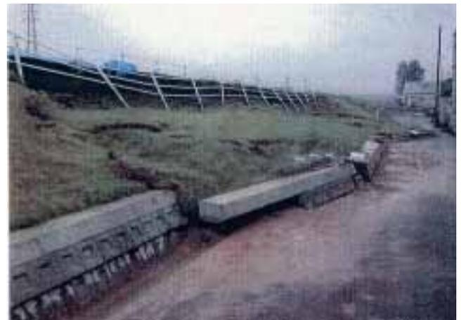
写真-1 堤体浸透破壊の一例
