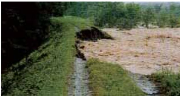
写真-3 直接侵食破壊の例
