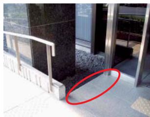
写真-1 (左) H15.9 県議会棟エントランス：調査点検時に落下の危険と手すりの不連続が指摘された。
