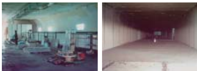
(模型トンネル外観) (模型トンネル内部)
