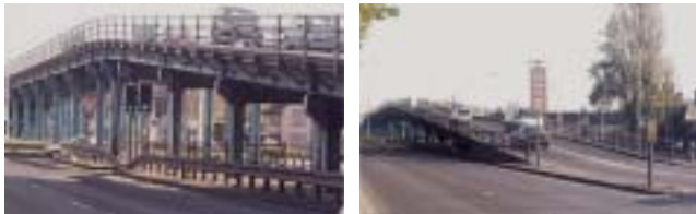
図-2 英国の乗用車専用道路（暫定スチール製フライオーバー）の事例
