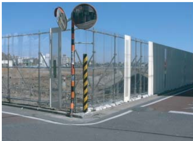
図－10 工事段階における交差点（仮囲い）の見通し確保
