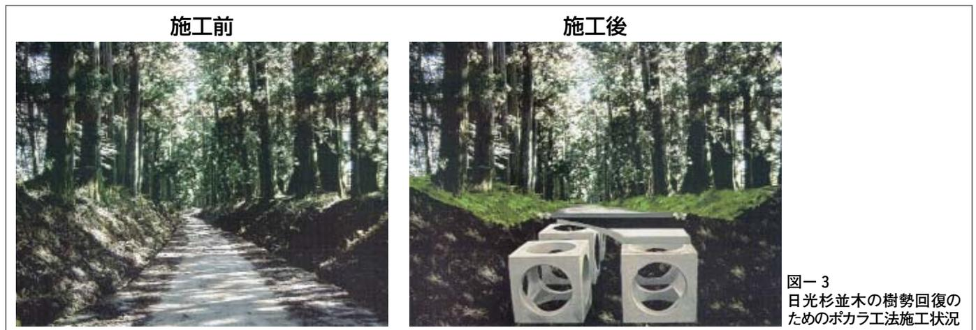
コンクリートブロックを地中に敷設し、その中に遅効性の堆肥等を混入した土壌を充填して法面の細根に養分を補給するとともに、ポカラの上に穴空床版コンクリートを打設して通行車両の車重を受け止めて、ポカラ内部の土壌を柔らかく保ち、根の生育しやすい空間を確保するための工法です。今市市市瀬川地区（写真6）で実施した結果、最も有効な方法であることがわかりましたが、幹線バイパスやミニバイパスの完成により、杉並木道の交通を制限しなければ実行できないので、今後それ以外の所では並木敷法面の土留め工法は、樹根の生育に必要な空気の流通を遮断する練石積工は避け、原則として木柵工法や土嚢積工法によることにしました。従って、今後練石積の所を上記の方法でやり直すことも大切です。
