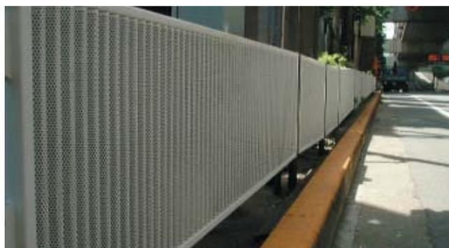
写真-5 吸音フェンス(光触媒塗布)
