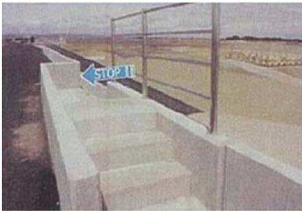
写真 4.2 特殊堤に避難階段を施工した事例
