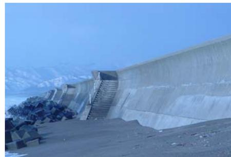
写真 4.3 防波堤に設置されている避難階段
