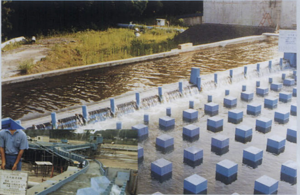
目黒川荏原地下地下調節池(東京都)
