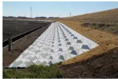
図 8-17 河川堤防の法面下端の保護事例
