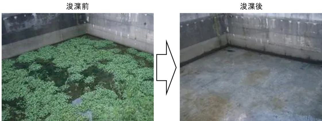
図 6-26 調整池における機能の保全のため定期的な浚渫作業の例（町田市ウェブサイトより）
