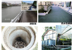
雨水貯留浸透施設の例
