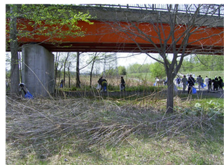
図 7-6 洪水後のごみの流入 （霞堤の遊水区域の例）
