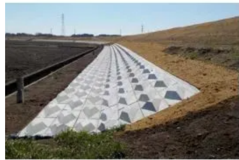
図 8-17 河川堤防の法面下端の保護事例
