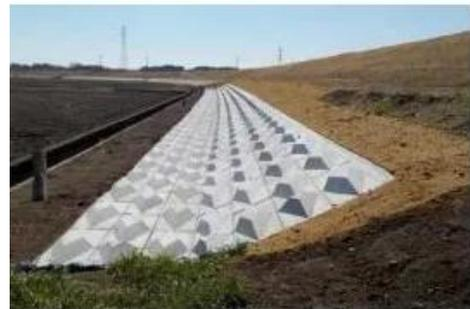
図 8-17 河川堤防の法面下端の保護事例
