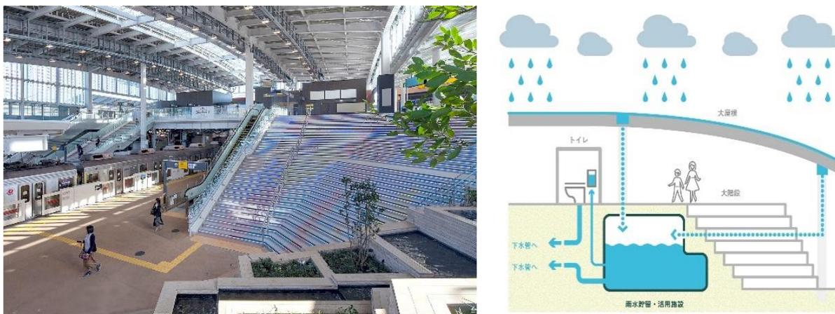
図4-2 雨水利用機能を兼ね備えた雨水貯留施設の事例（南町田グランベリーパーク）
