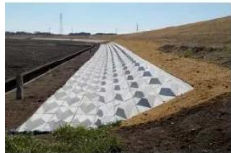
図 8-17 河川堤防の法面下端の保護事例
