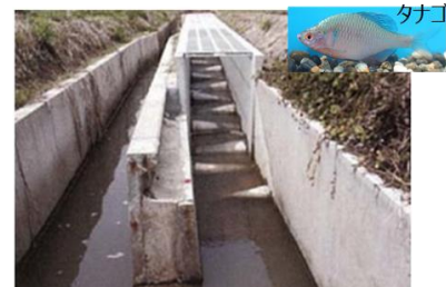
図 7-3 河川の連続性が確保された環境の様子
