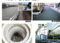
雨水貯留浸透施設の例
