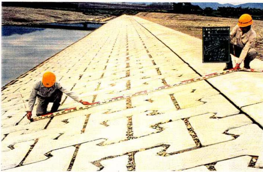
写真5.4 空張り護岸型（コンクリートブロック張り）の設置例（東北地方建設局）
