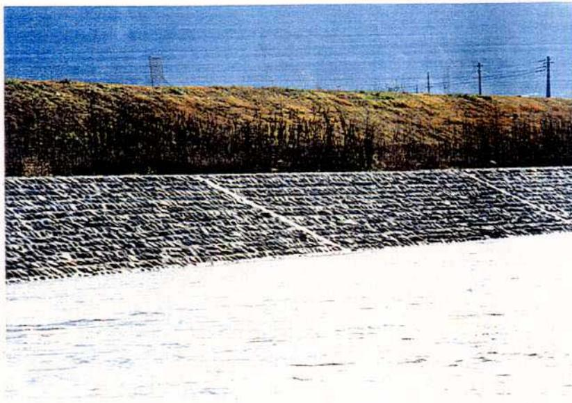
写真5.1 練張り護岸型の設置例（関東地方建設局）
