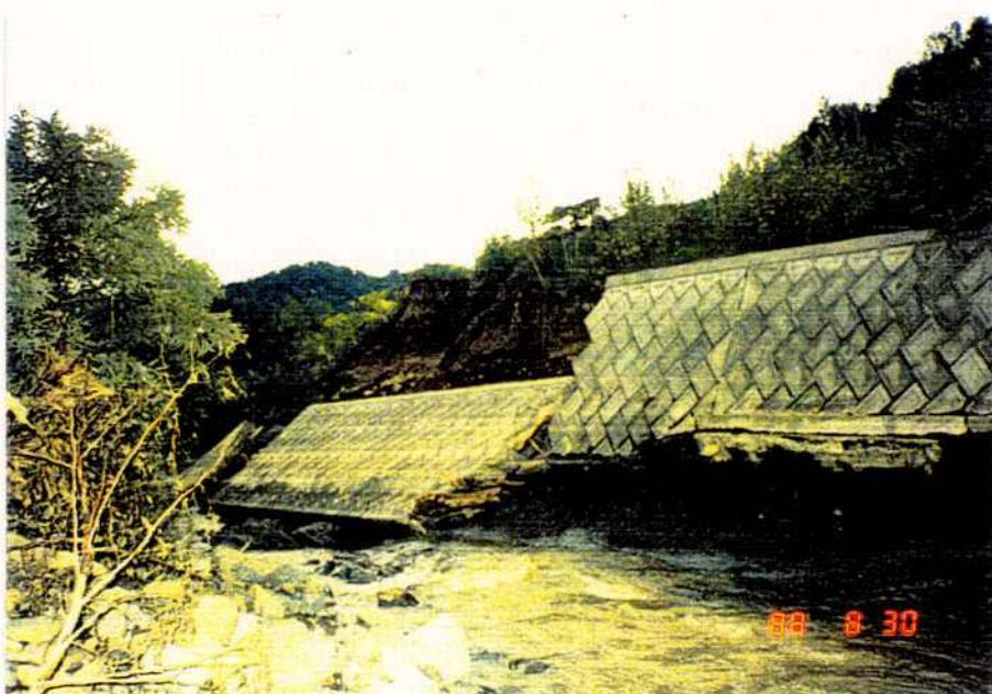
写真1.3 河床洗掘による護岸被災事例（北海道開発局）
