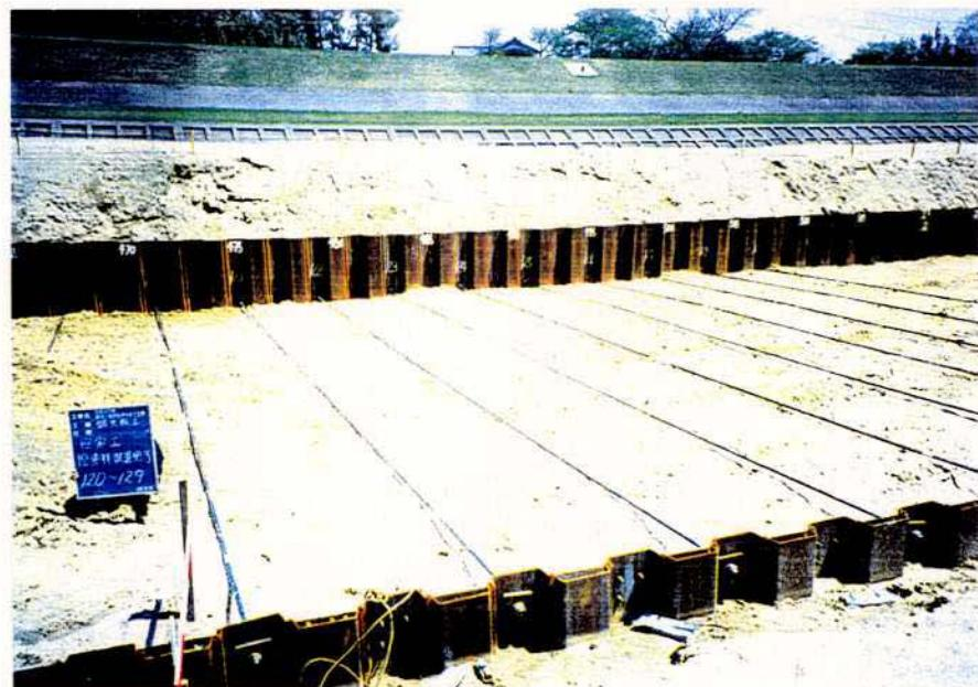
写真5.14 矢板護岸型（控え式）の設置例（中部地方建設局）
