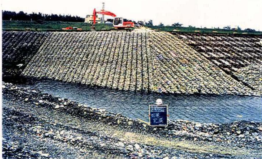
写真5.16 蛇籠の護岸設置例（中部地方建設局）
