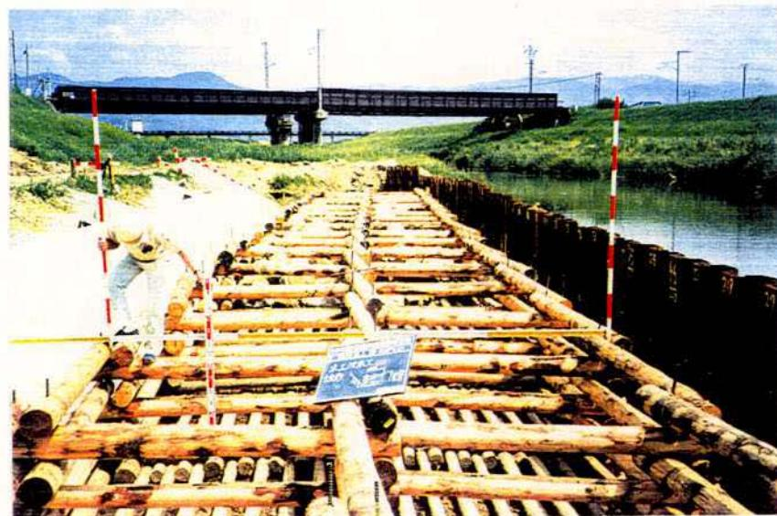
写真5.28 木工沈床型（詰石前）の設置例（九州地方建設局）
