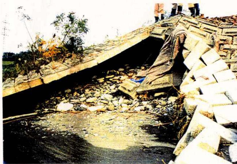
写真1.7 連節ブロック背面堤防土砂の流出状況（中部地方建設局）
