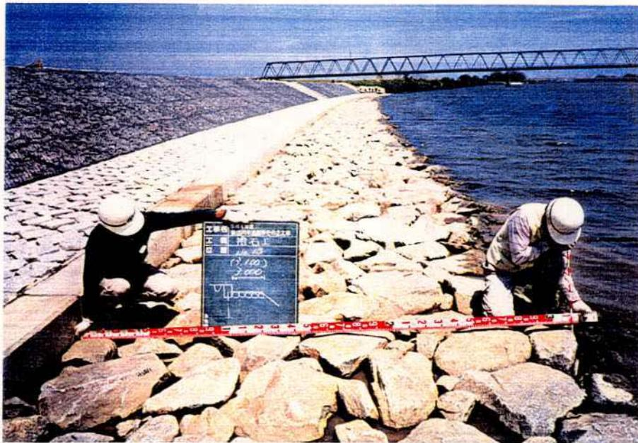
写真5.23 捨石型の設置例（中部地方建設局）
