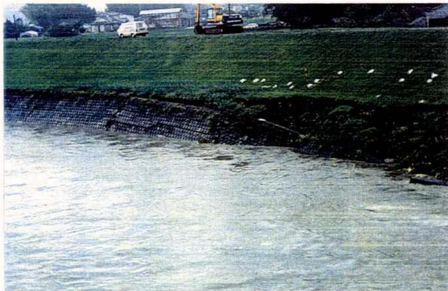
写真1.4 河床洗掘による護岸被災事例（九州地方建設局）
