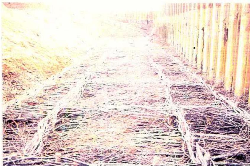
写真5.26 そだ沈床型（詰石前）の設置例（東北地方建設局）
