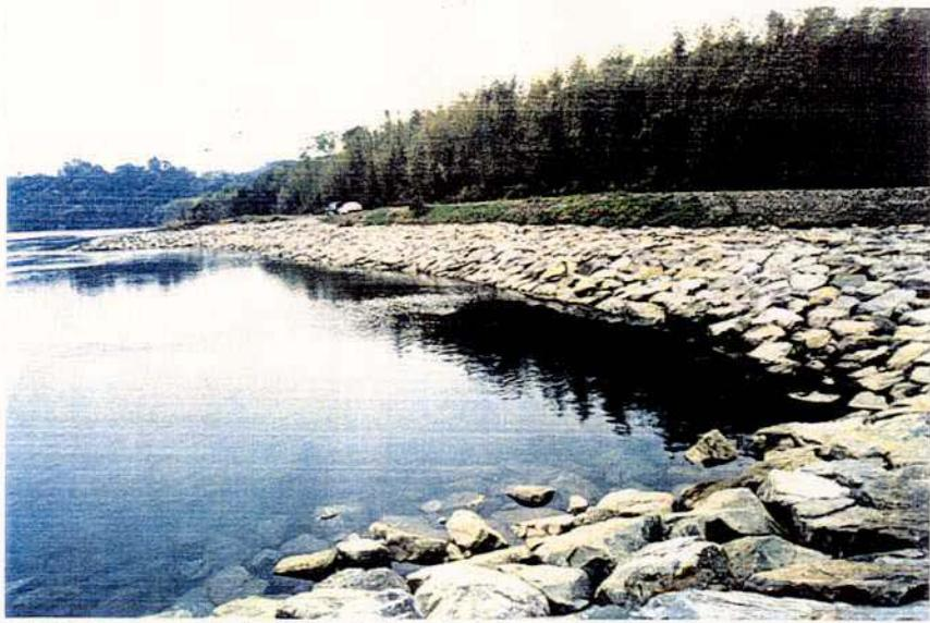
写真5.3 空張り護岸型（石張り）の設置例（四国地方建設局）
