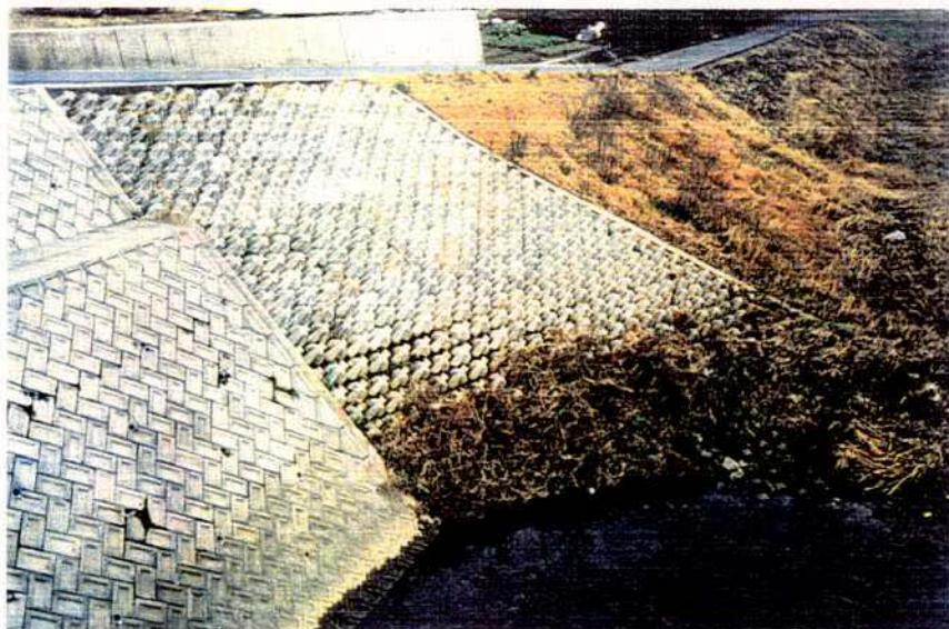
写真5.11 すり付け護岸型（ブロックマット）の設置例（四国地方建設局）
