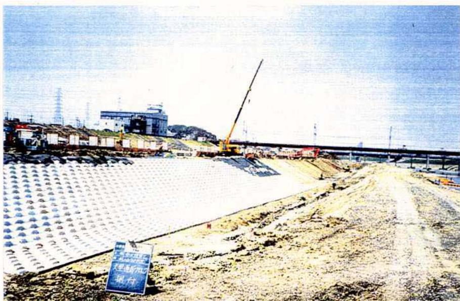
写真5.5 空張り護岸型（大型連続ブロック+吸い出し防止シート）の設置例（近畿地方建設局）
