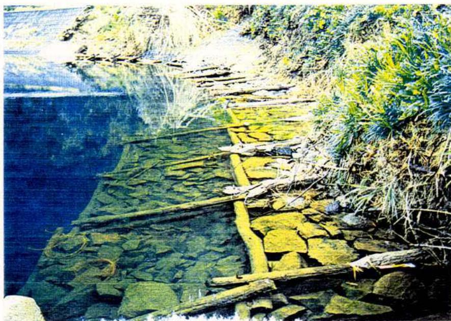
写真5.27 木工沈床型の設置例（九州地方建設局）
