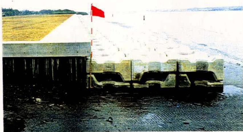
写真5.20 異形ブロック連節層積み型の設置例（関東地方建設局）
