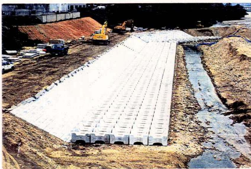
写真5.19 異形ブロック連節層積み型の設置例（中部地方建設局）
