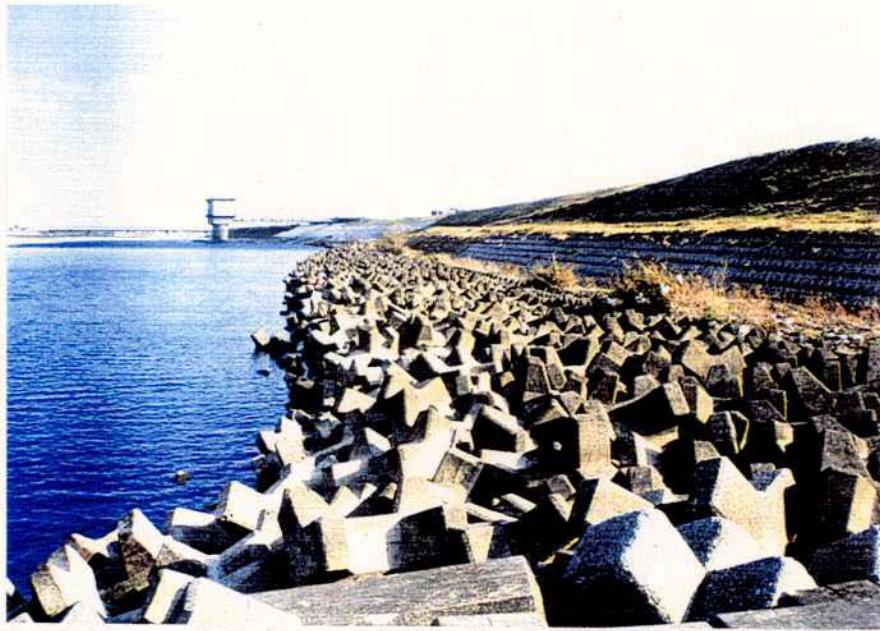
写真5.21 異形ブロック乱積み型の設置例（四国地方建設局）
