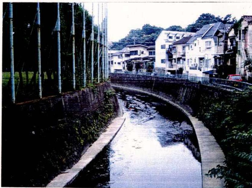
写真5.9 擁壁護岸型の設置例
