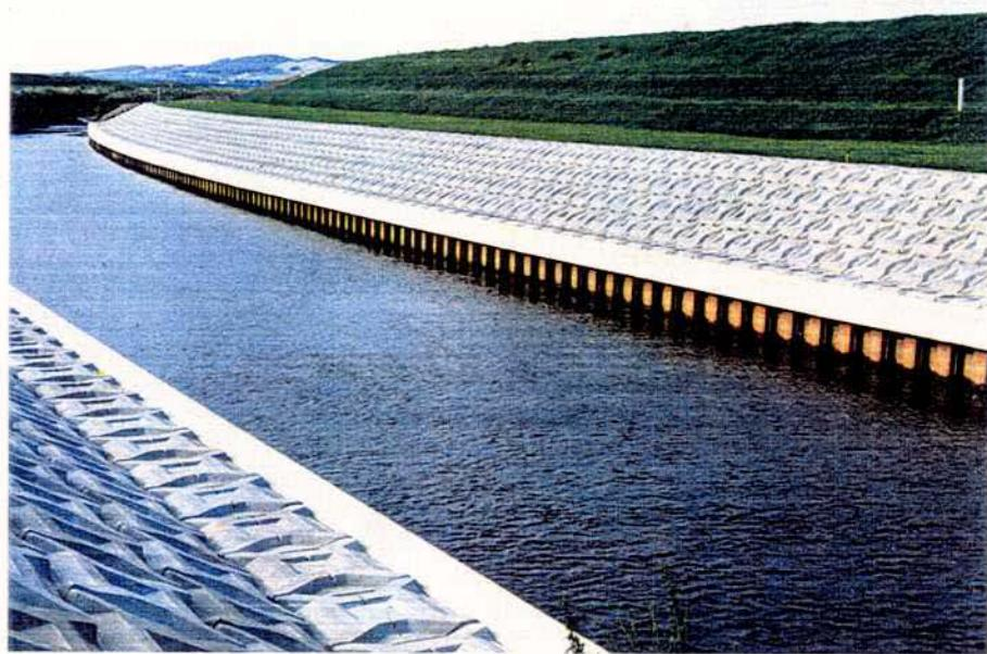
写真5.13 矢板護岸型の設置例（北海道開発局）
