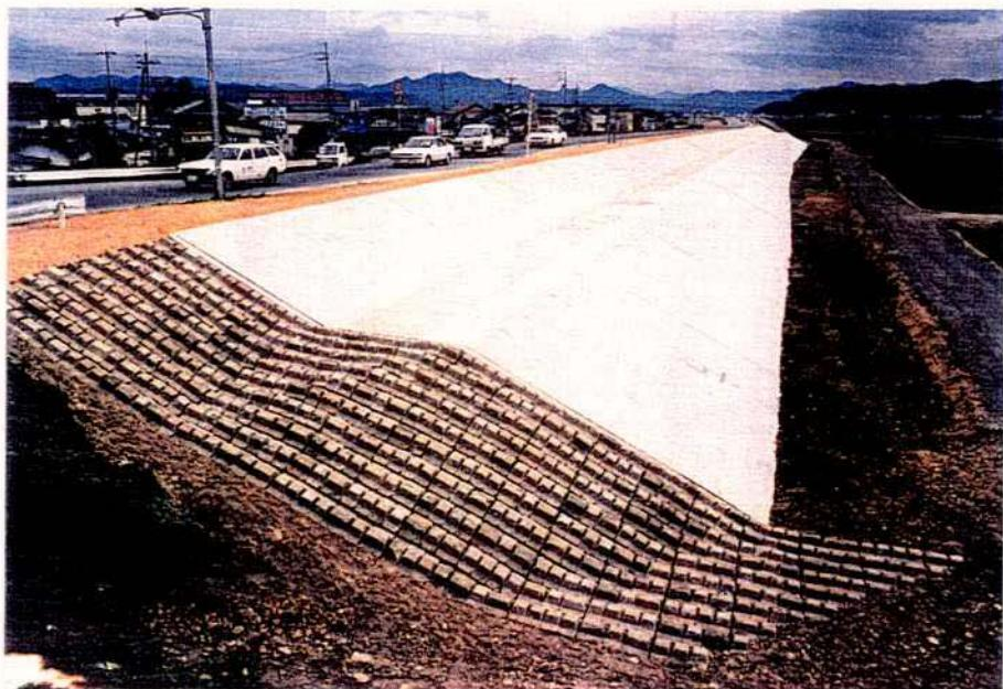
写真5.10 すり付け護岸型（連節ブロック）の設置例（近畿地方建設局）
