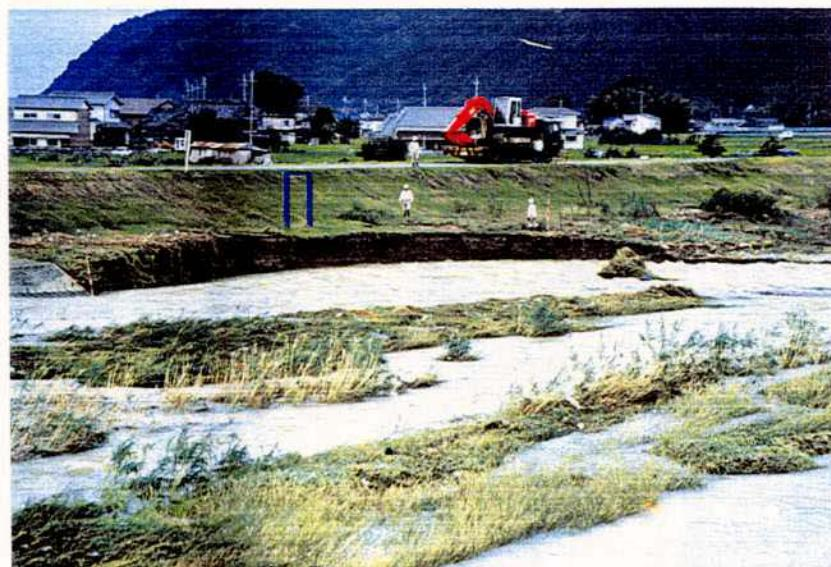
写真1.2 護岸直下流部の河岸侵食事例（近畿地方建設局）
