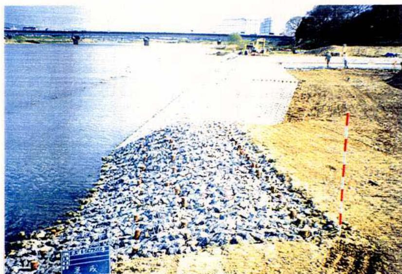
写真5.12 すり付け護岸型（布団籠）の設置例（近畿地方建設局）
