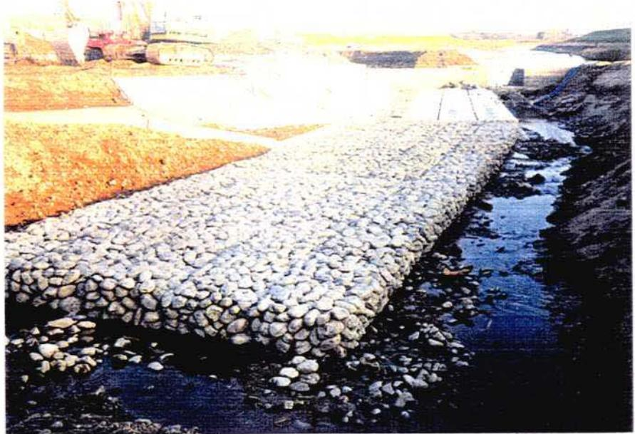
写真5.29 篠工型の設置例（中部地方建設局）
