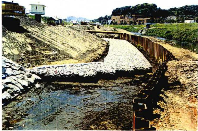
写真5.30 篠工型の設置例（九州地方建設局）
