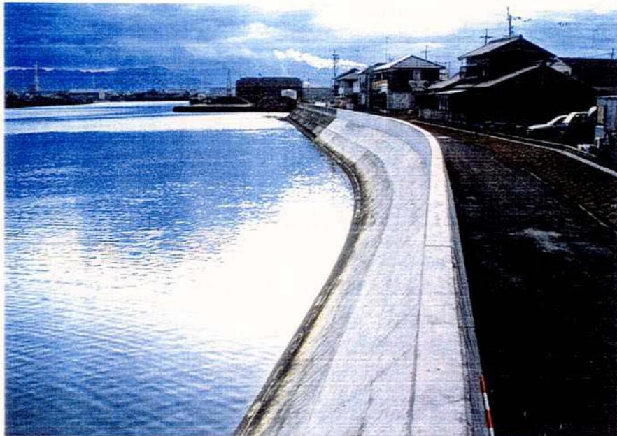
写真5.8 擁壁護岸型の設置例（四国地方建設局）
