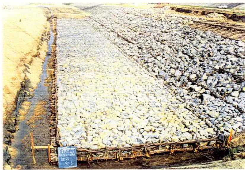
写真5.25 そだ沈床型の設置例（中部地方建設局）
