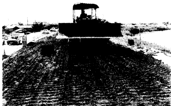
写真4.3.7 ブルドーザによる締固の状況（九州地方建設局）
