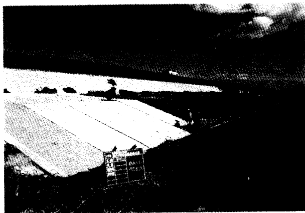
写真3.3.1 遮水シート工（北海道開発局）
