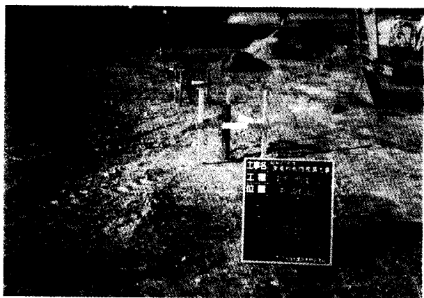
写真5.7.2 変位杭の設置状況（中部地方建設局）
