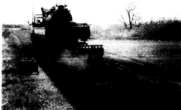
写真4.3.1 工事用道路の防じんのためのアスファルト乳剤散布 (関東地方建設局)
