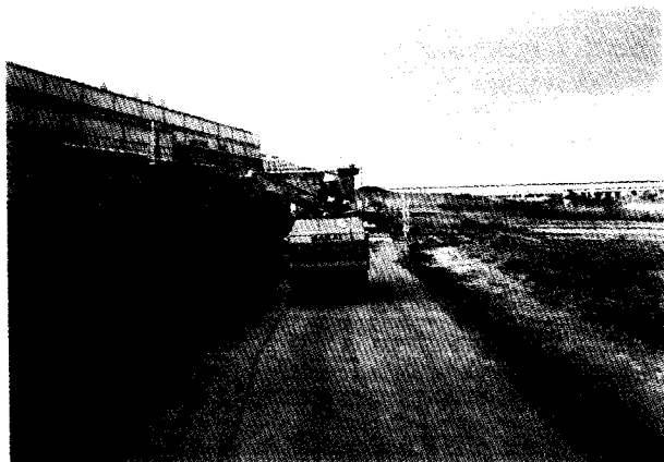
写真4.3.15 拡築部の締固め状況—振動ローラー—（中国地方建設局）
